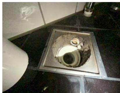
Kontroll av sluk.
