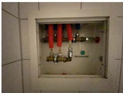
Besiktigelse av røropplegg.
