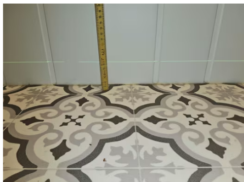
Kontrollmåling av etasjeskille er utført med nivelleringslaser.
