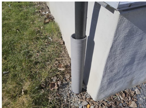
Taknedløp er avsluttet i drensrør.
