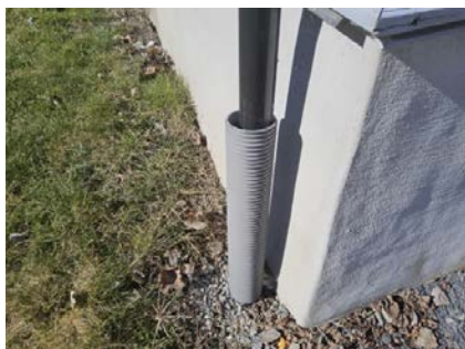
Taknedløp er avsluttet i drensrør.
