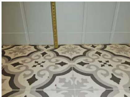
Kontrollmåling av etasjeskille er utført med nivelleringslaser.
