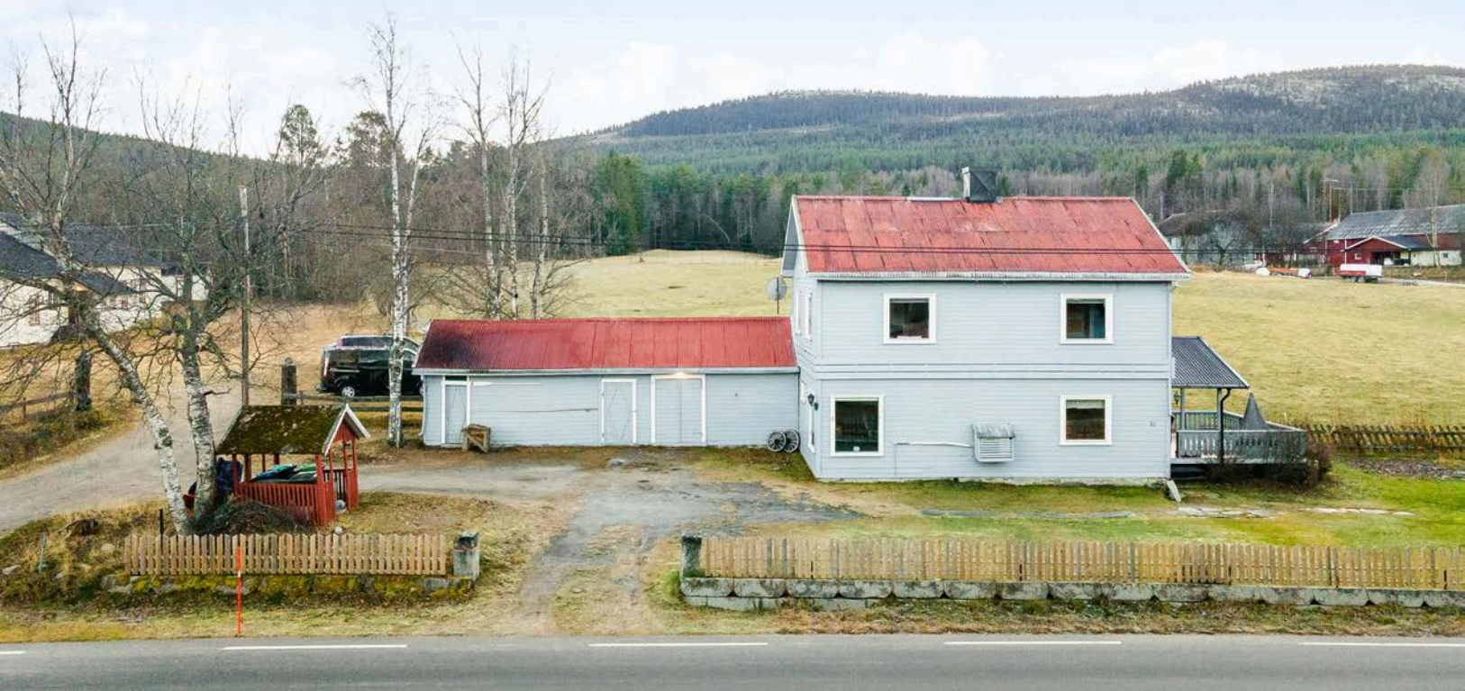
Inntilbygget garasje, bod og verksted som har videre adkomst til stuen i 1. etasje.
