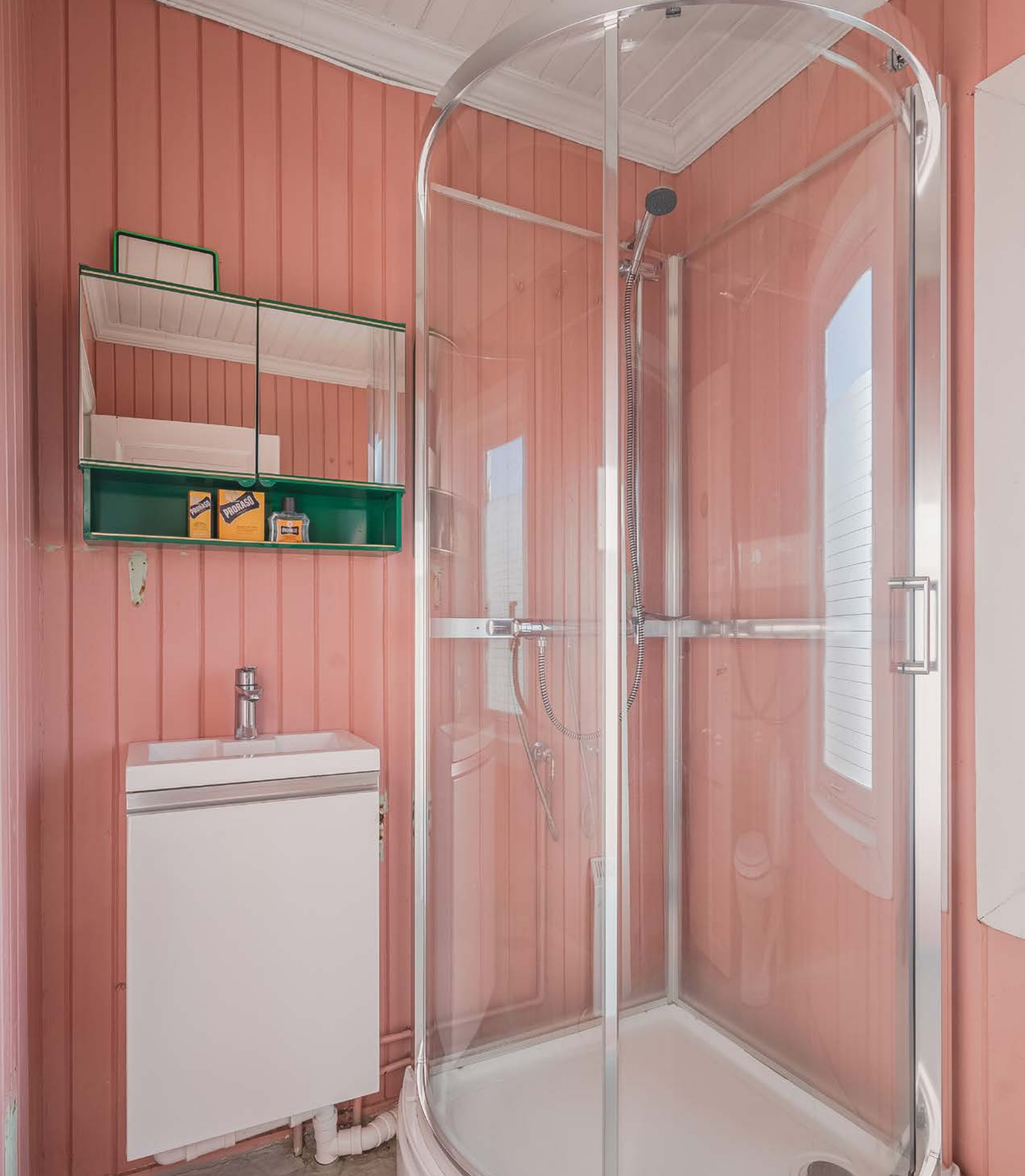
Eldre baderom i 2. etasje med fliser på gulv og overflater med malt panel. Montert dusjkabinett i 2019 som hindrer direkte vannsprut på overflatene, men baderommet må oppgraderes for å tåle normal bruk etter dagens krav.
