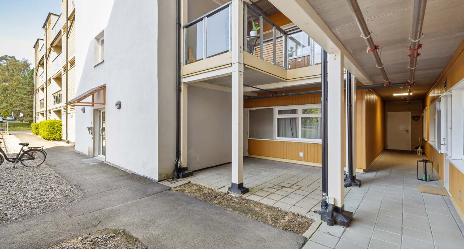
Inngangsparti til bygget er også belagt med steinheller.
