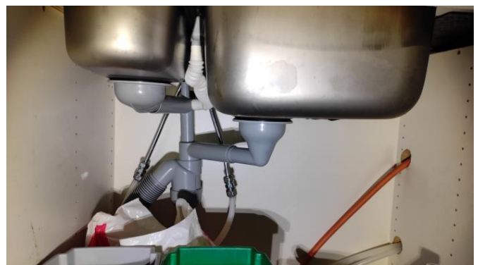
Kontroll av røropplegg.
