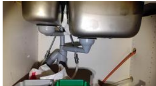
Kontroll av røropplegg.
