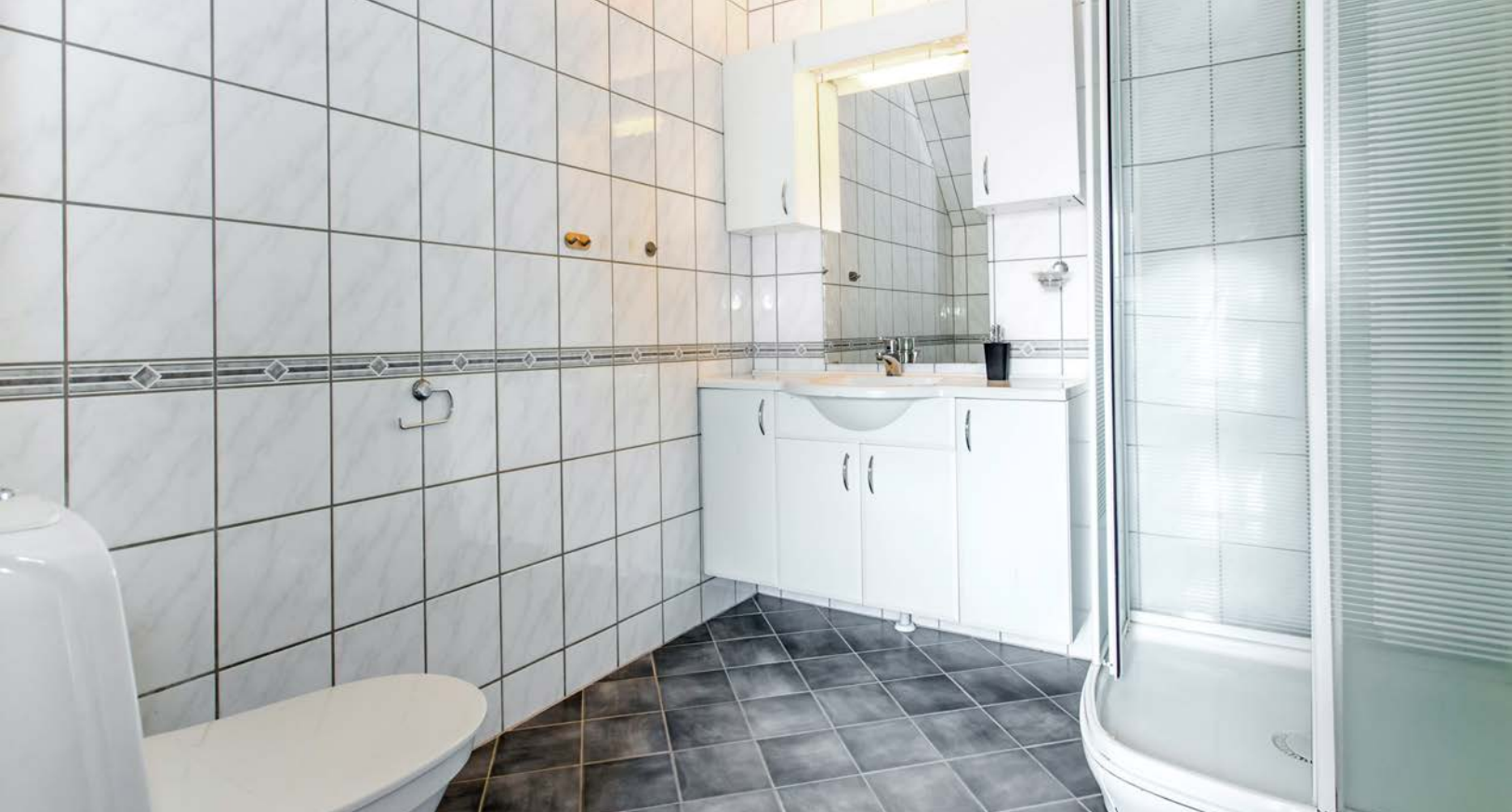
Varme i gulv på bad/wc, stue og gang i 2.etasje. Innmontert 1 dusjkabinett, 1 klosett, 1 servant og opplegg for vaskemaskin.
