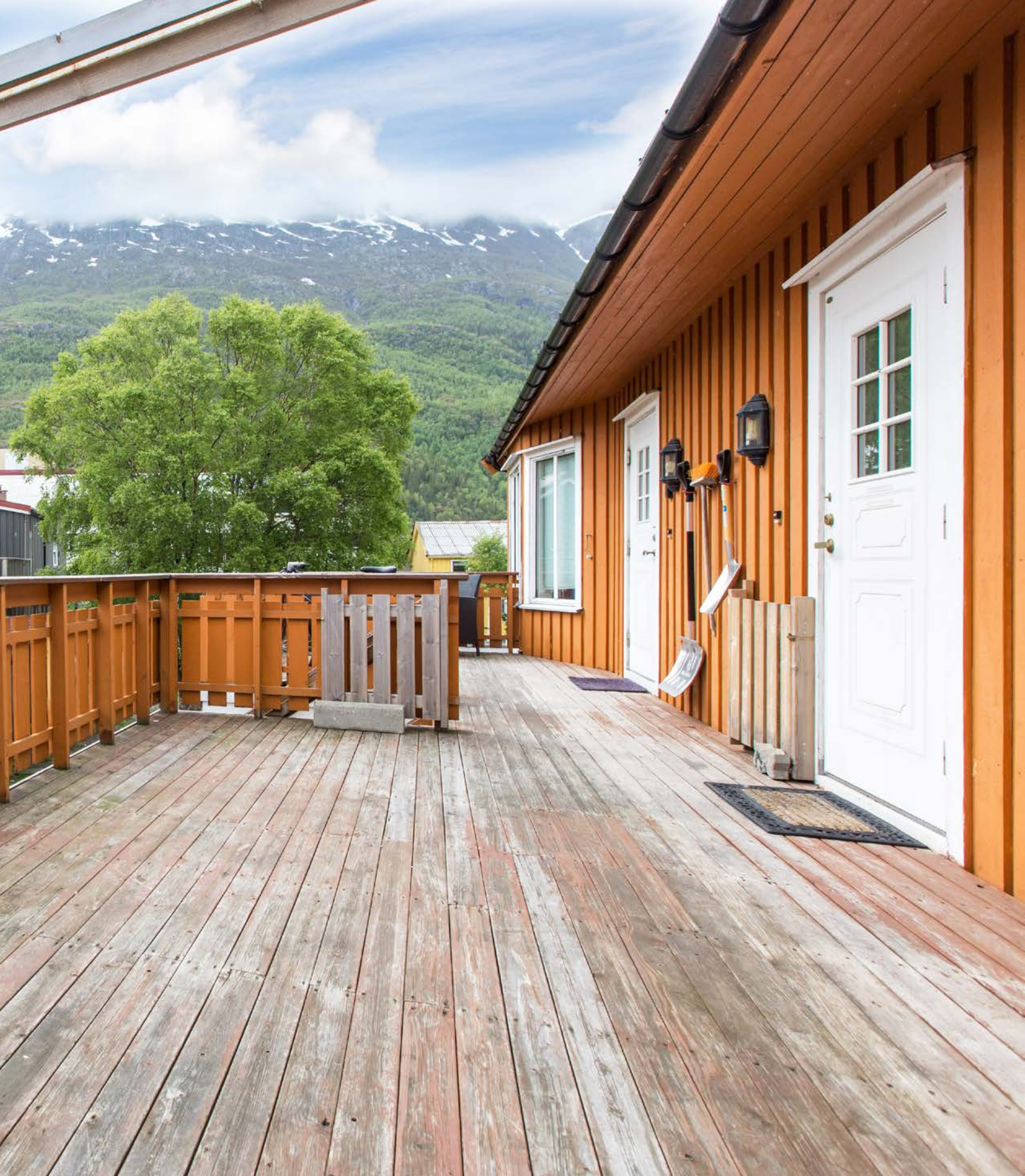
Terrasse på ca. 16 m 2 mot sør på inngangssiden
