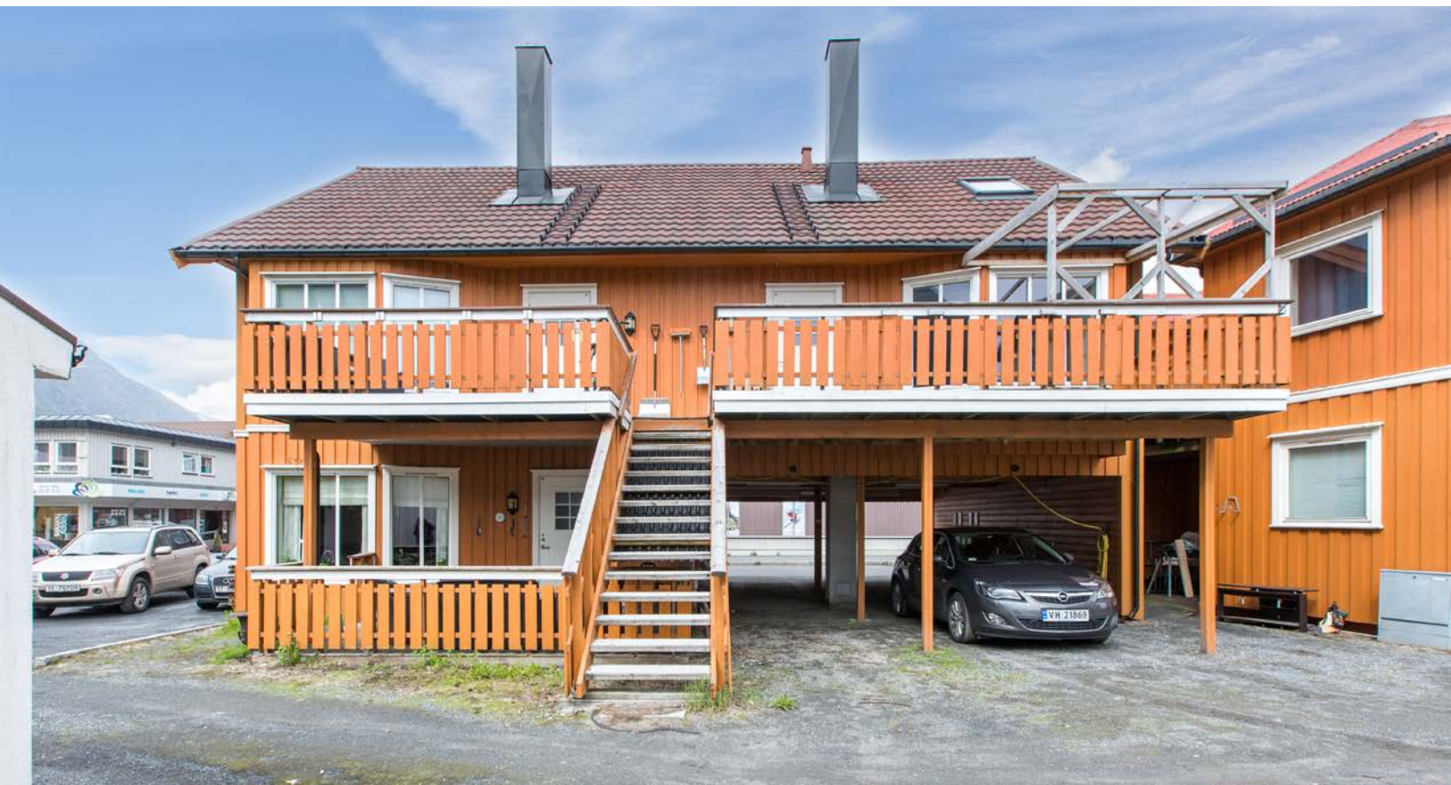
Fasade og carport. Felles utvendig trapp for leilighetene i 2. etasje.
