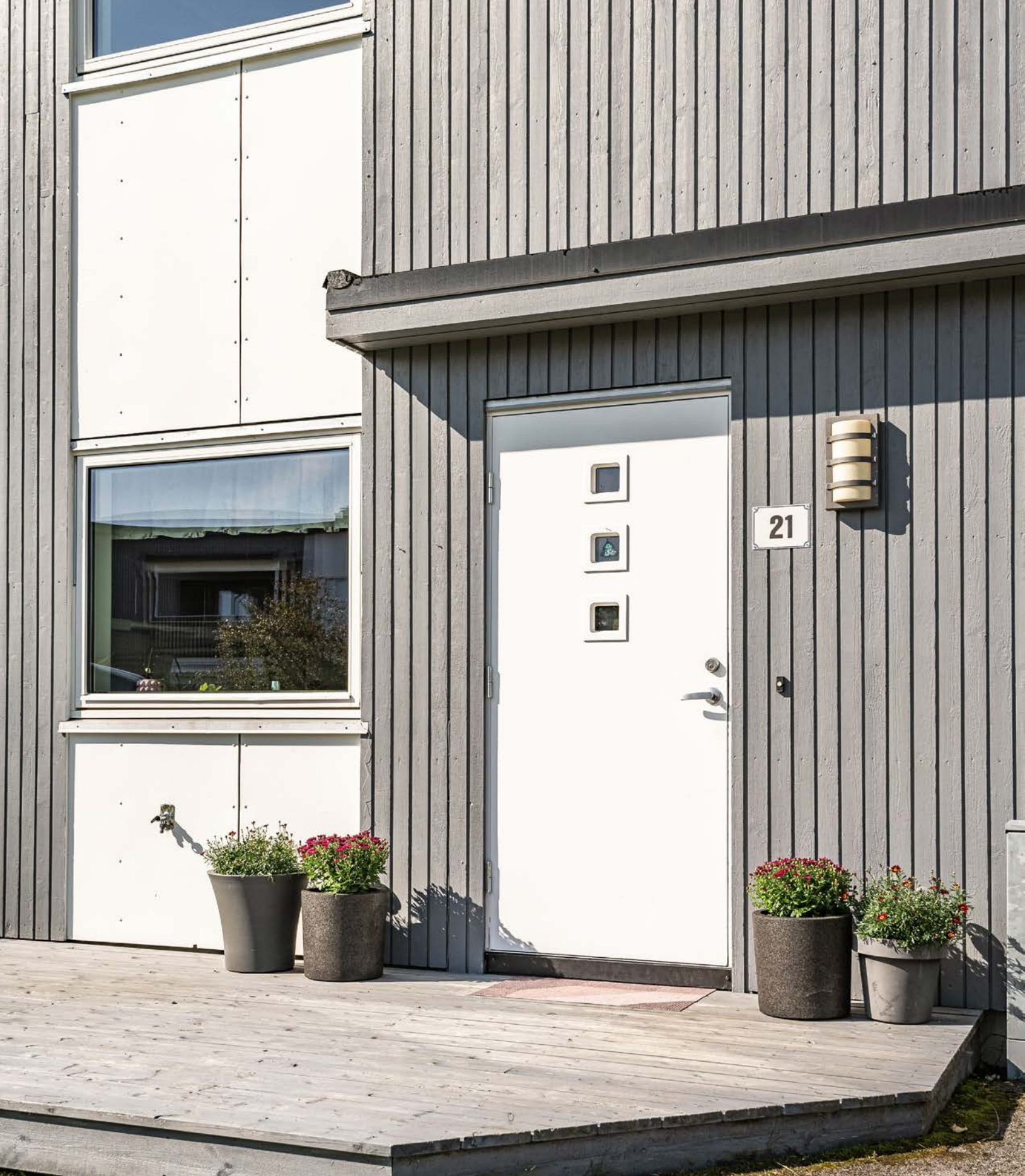
Koselig inngangsparti med terrasseplattning på ca. 10 kvm.
