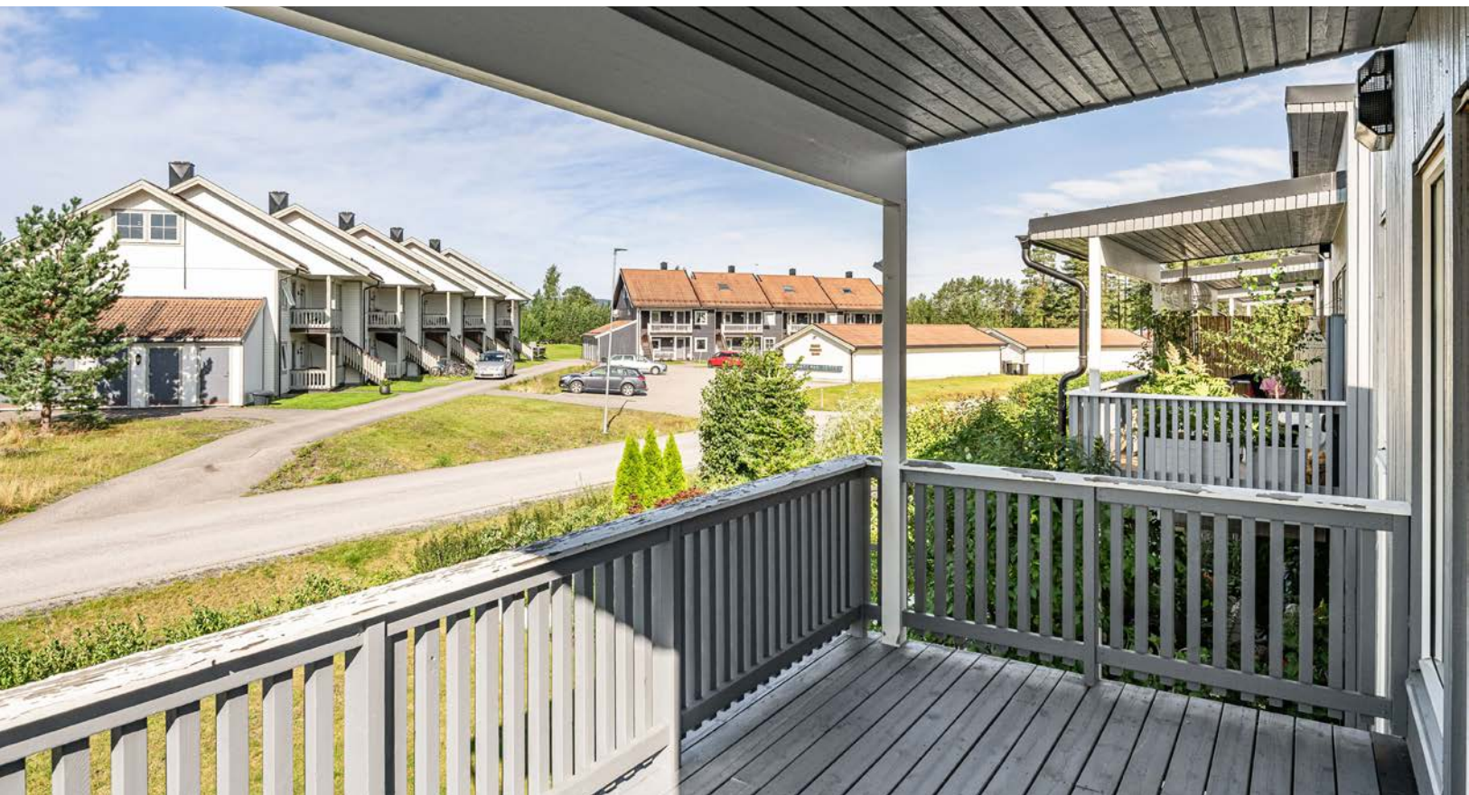
Balkongen i 2. etasje har terrassebord og beiset-malt rekkverk.
