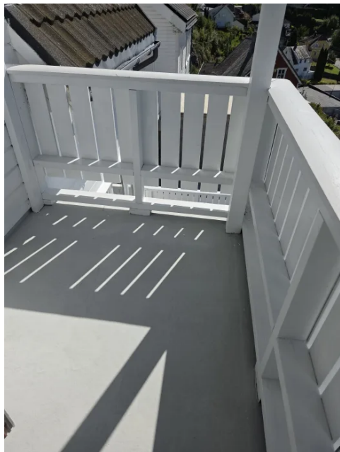
Bilde av glassfibertekking på balkong.
