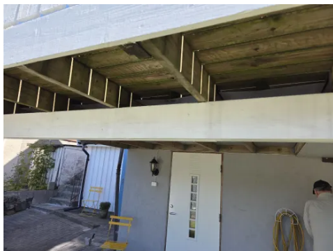
Oversiktsbilde fra undersiden av terrassen.
