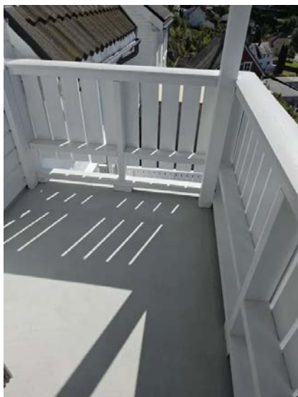
Bilde av glassfibertekking på balkong.
