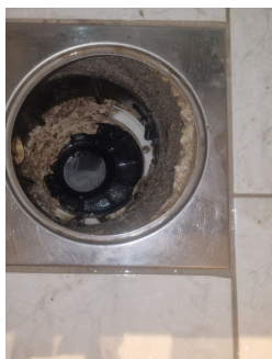
Sluk med klemring for membran
