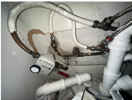
Rørproppleg i kjøkkenbenk med Waterguard
