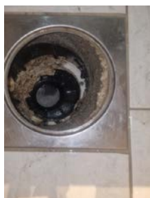
Sluk med klemring for membran
