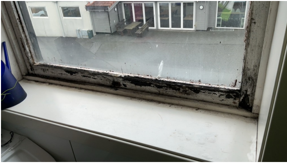
vindu på bad.
