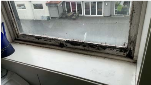
vindu på bad.
