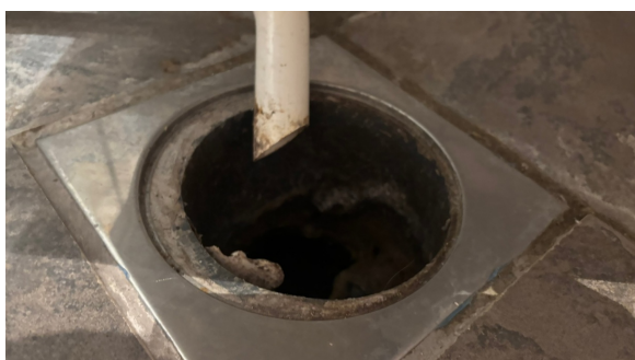
Eldre sluk i støpejern
