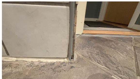
Noen uheldige løsninger på flisene/avslutninger
