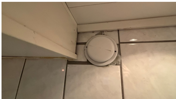
Noen uheldige løsninger på flisene
