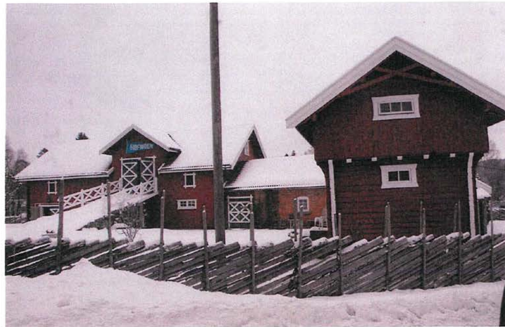
Tunet på Hofmoen ligger like inntil Klapputveien og er et viktig miljøskapende element i denne delen av bygda.
