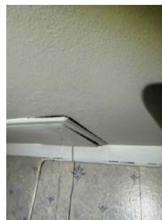
Bilder viser tegn til noe svelling rundt ventilen i taket.
