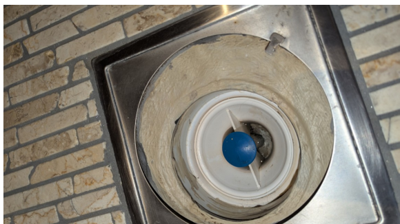
Smøremembran pålimt flens
