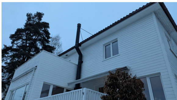
Stålpipes uten plattform.
