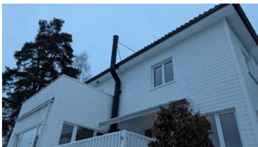
Stålpipe uten plattform.
