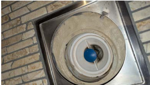
Smøremembran pålimt flens
