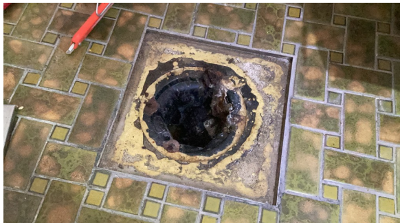
Sluk av plast. Det er ikke tegn til membran
