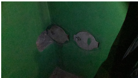
Sotluke i kjeller.
