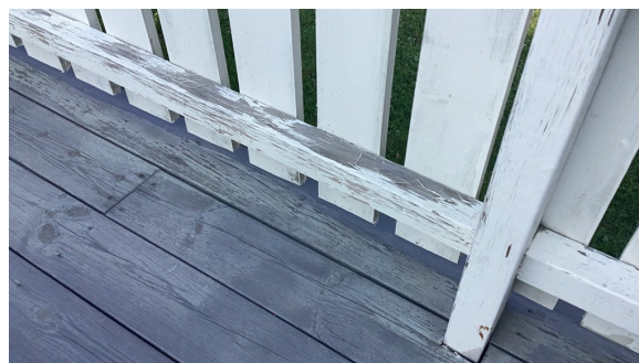
Eksempel på slitasje på overflater.
