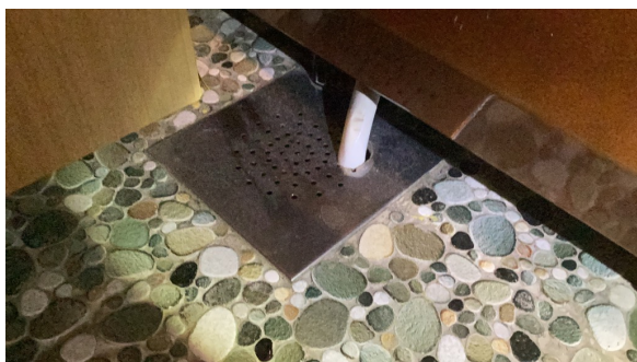
Slukrist sitter fast og sluk er ikke inspisert.
