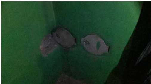
Sotluke i kjeller.
