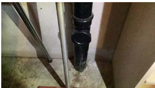
Stakepunkt i kjeller.
