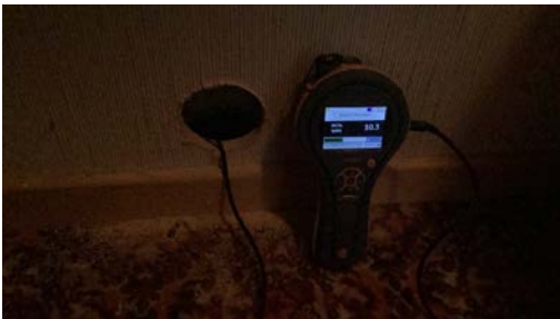
Fuktmåling i vegg uten skadelig fuktinnhold.
