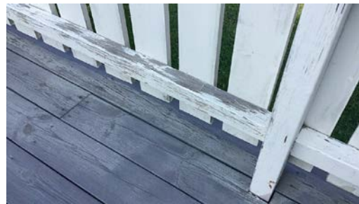
Eksempel på slitasje på overflater.
