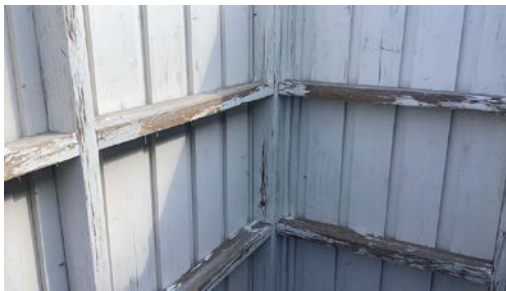
Eksempel på slitasje på overflater.
