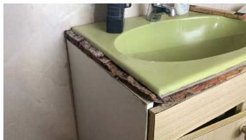
Skade på servanttinnredning.
