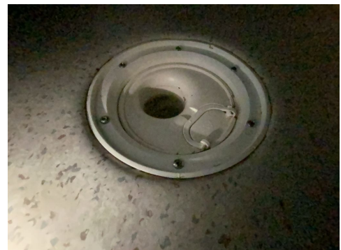
Kontroll av sluk.
