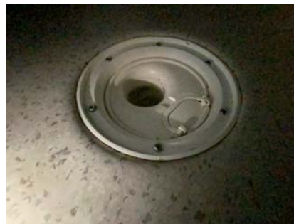
Kontroll av sluk.
