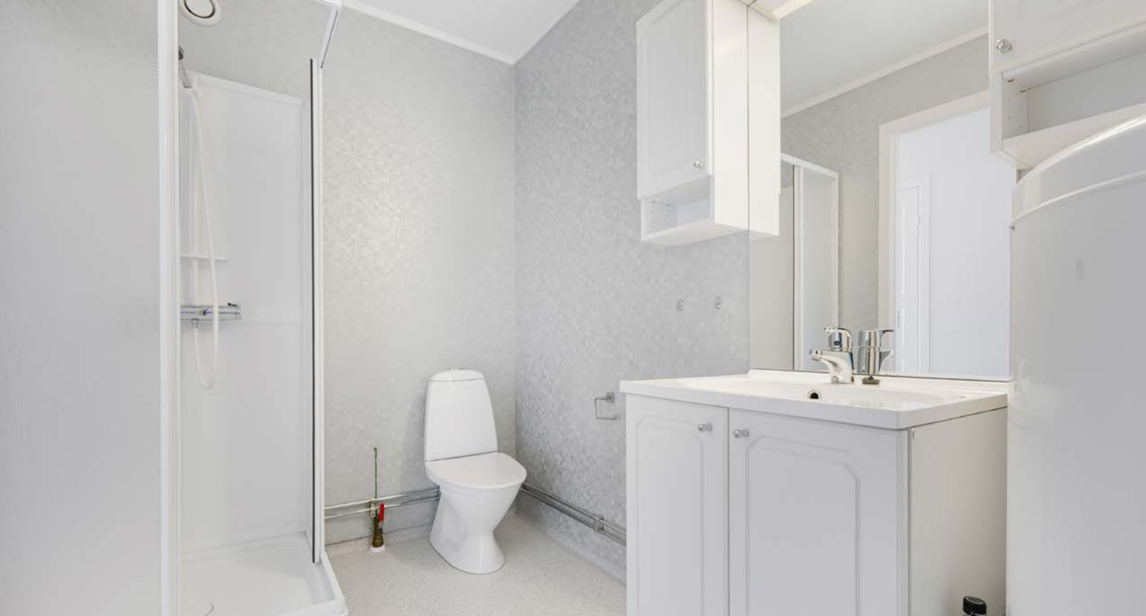
Baderom med gulvbelegg, våtromstapet på vegger, dusjkabinett, klosett, servant på servantskap og 200 L varmtvannsbereder.
