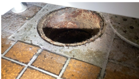
Kontroll av sluk.
