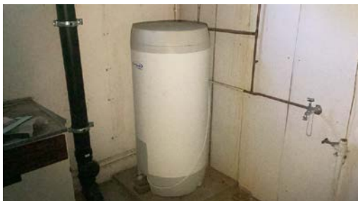
Varmtvannstank.
