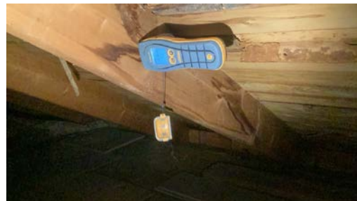
Ved enkel fuktmåling registrerte jeg tørre verdier.
