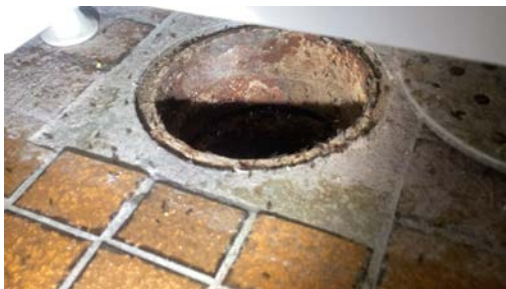
Kontroll av sluk.
