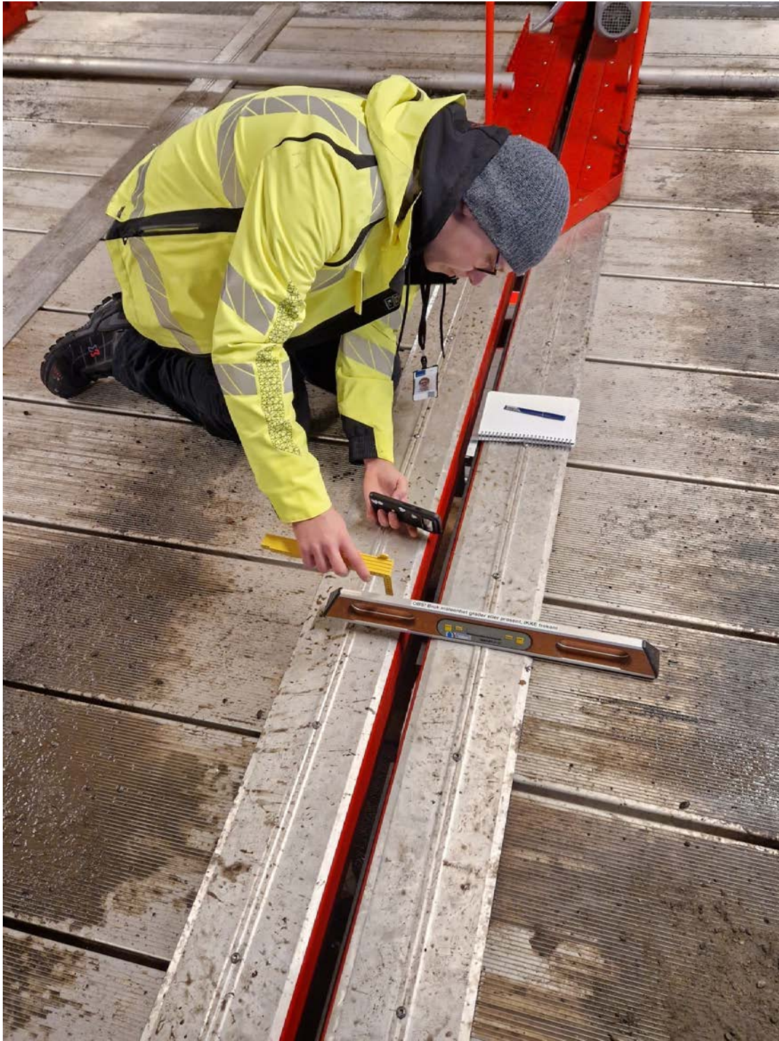
Foto 70: Grensesnitt mellom plattformer
