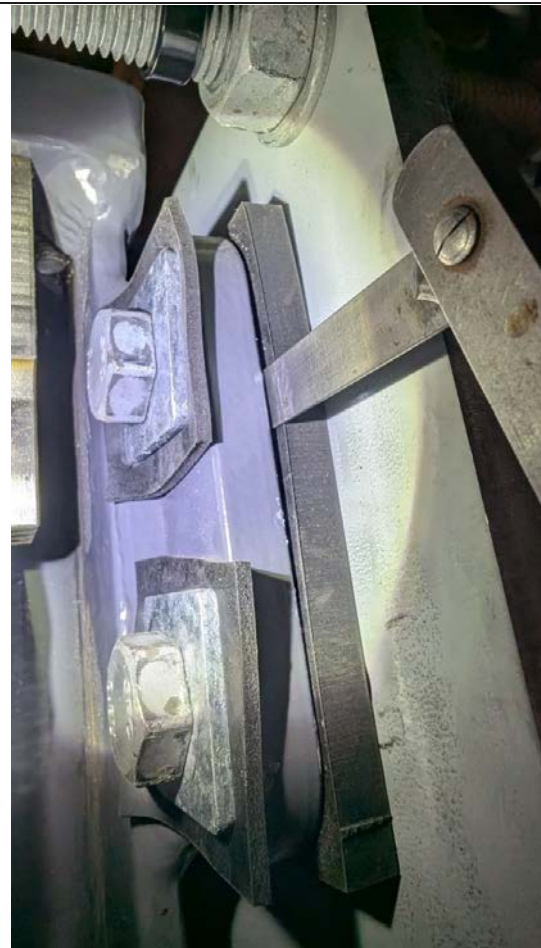
Foto 20: Klaring mellom braketter søyle, BK2
