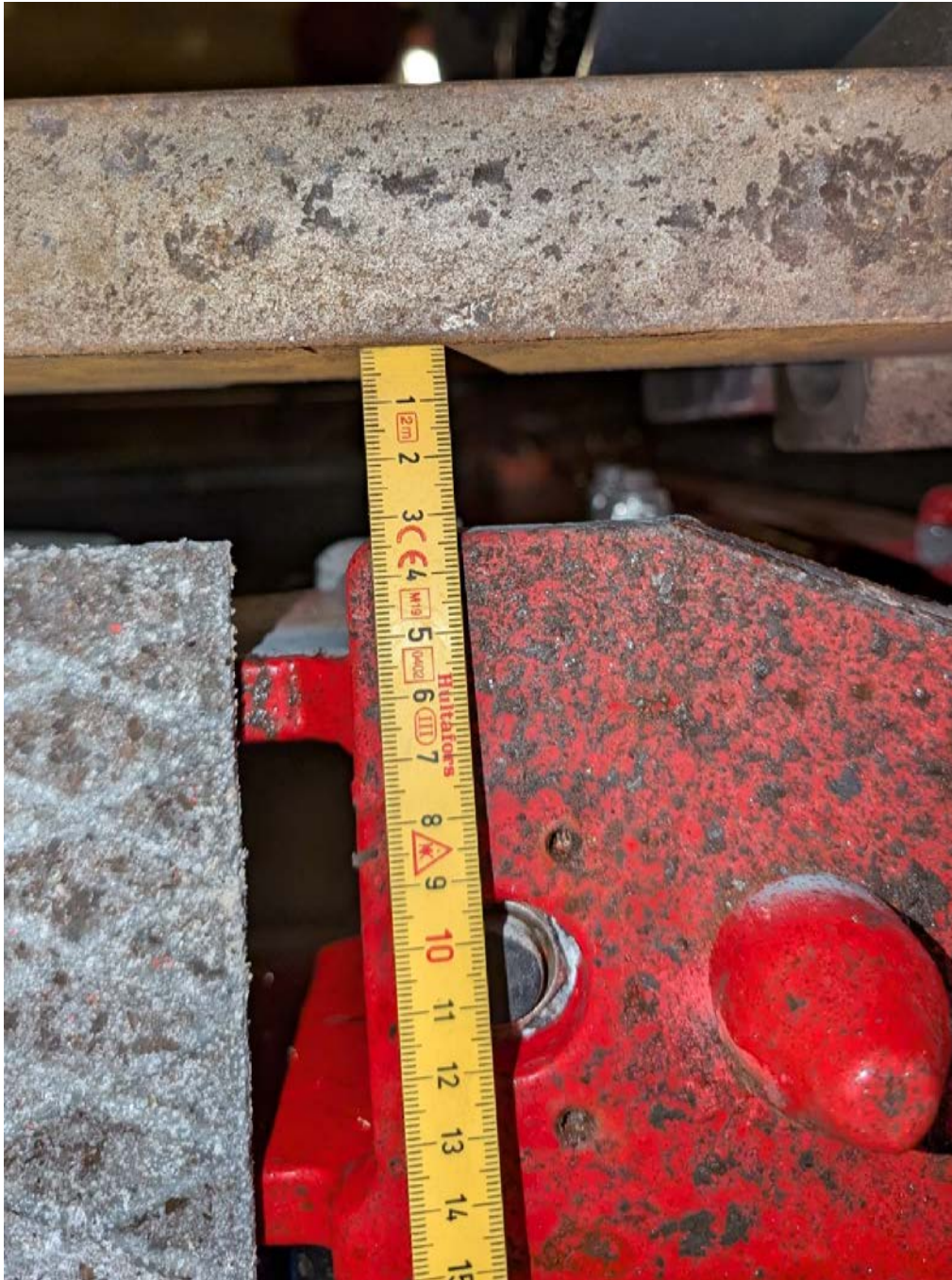
Foto 44: God klaring mellom plattform og skinne
