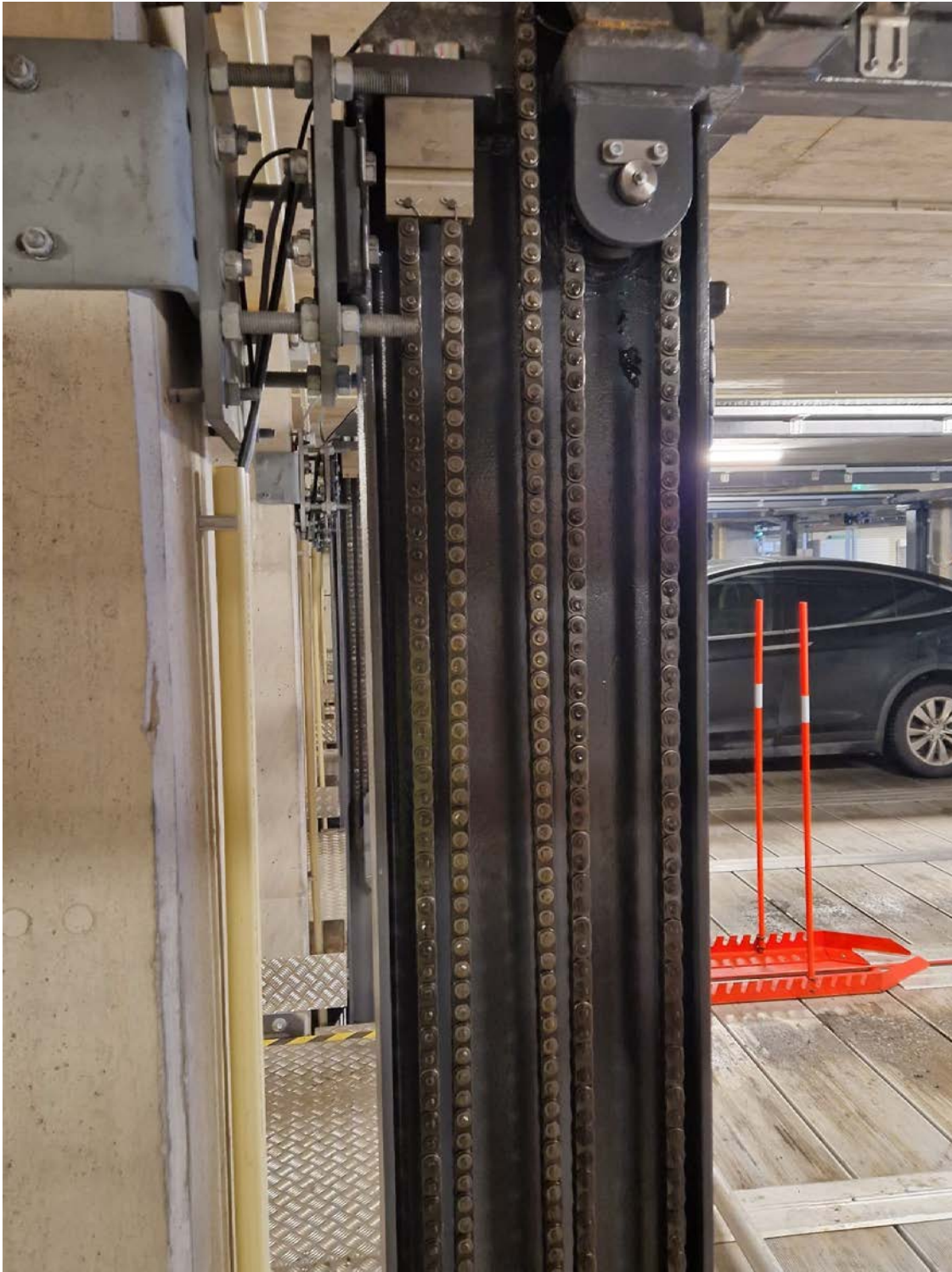
Foto 66: Innfesting mot søyle
