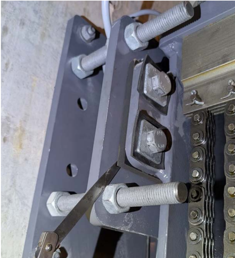
Foto 18: Klaring mellom braketter (1mm), BK1 vegg
