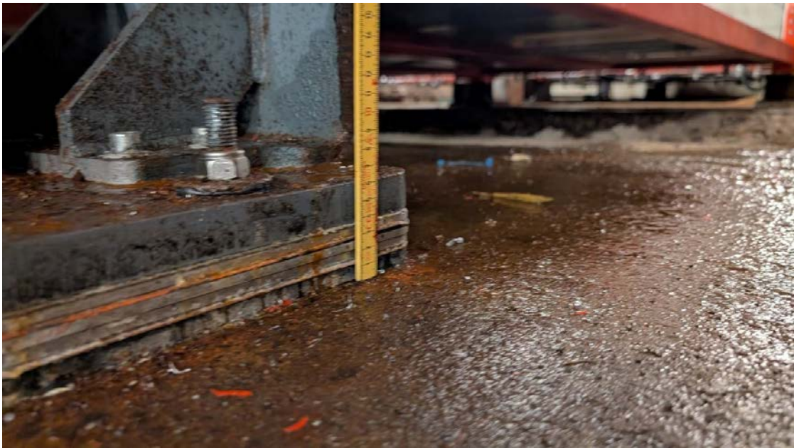
Foto 15: Demping mellom plate og bolteforbindelse
