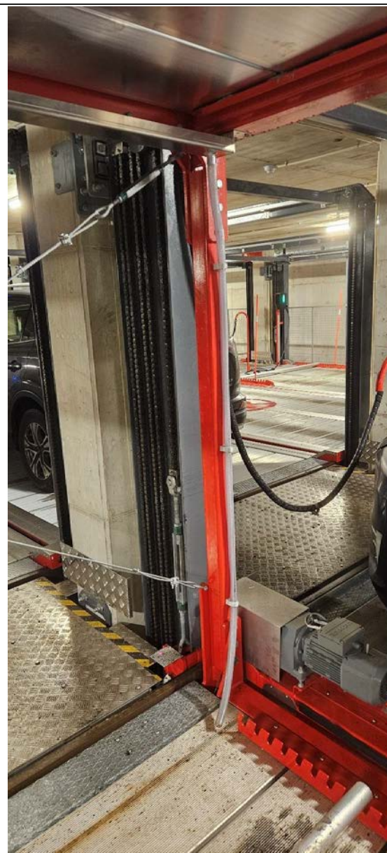
Foto 64: Avløp fra plattform over
