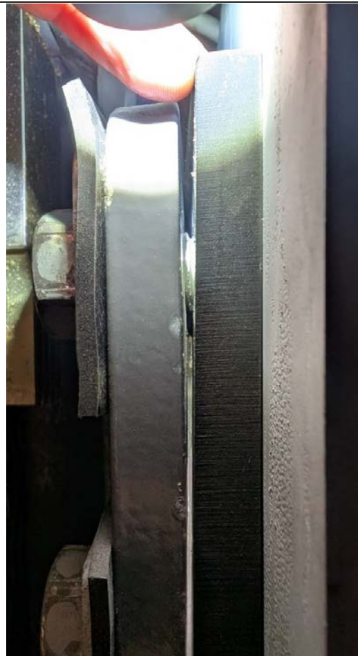
Foto 21: Klaring mellom braketter søyle, BK2
