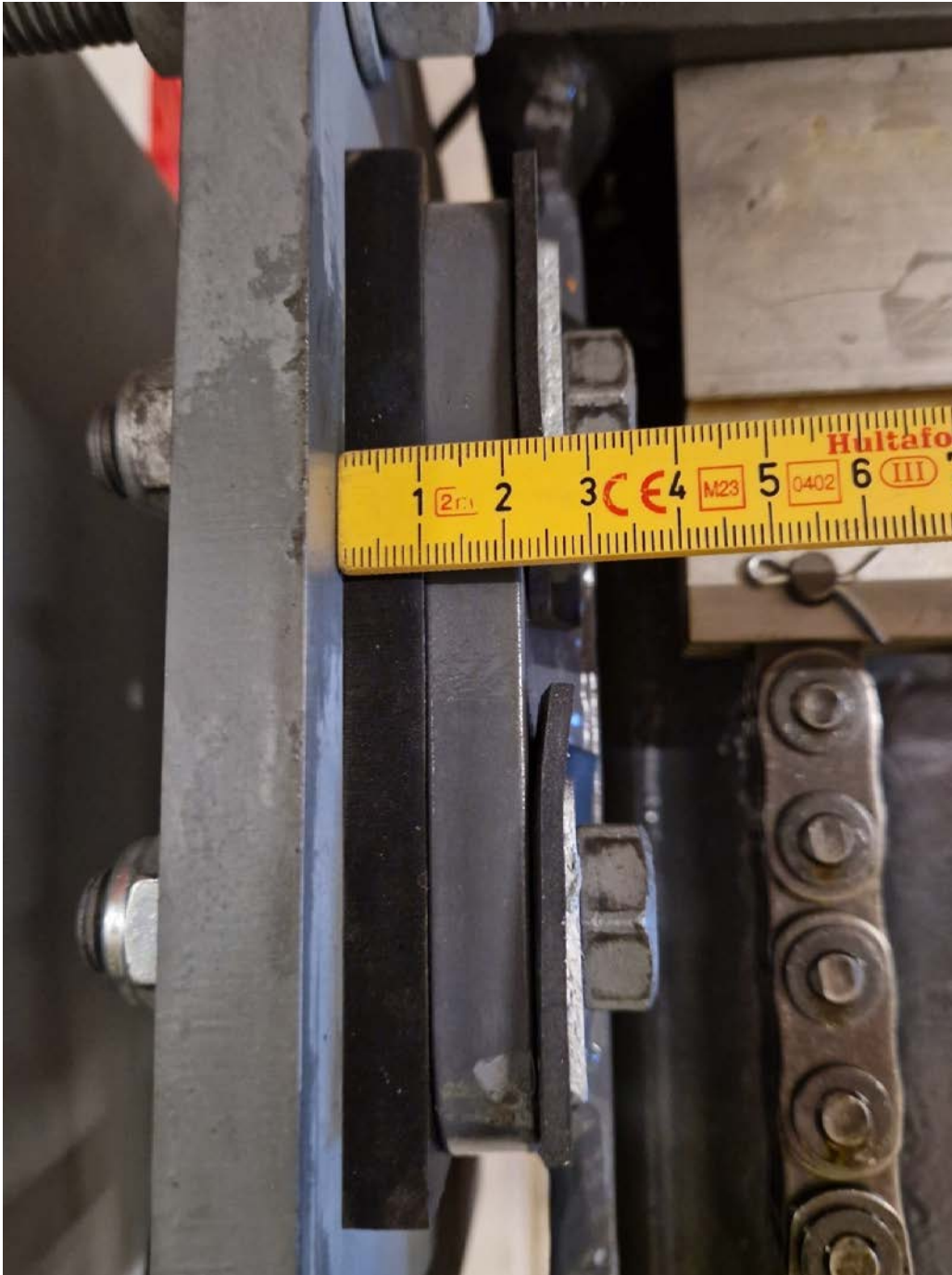
Foto 68: Innfesting mot søyle
