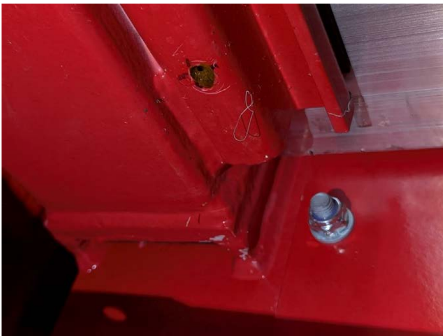
Foto 34: Hull for drenering over renne i plattformen
