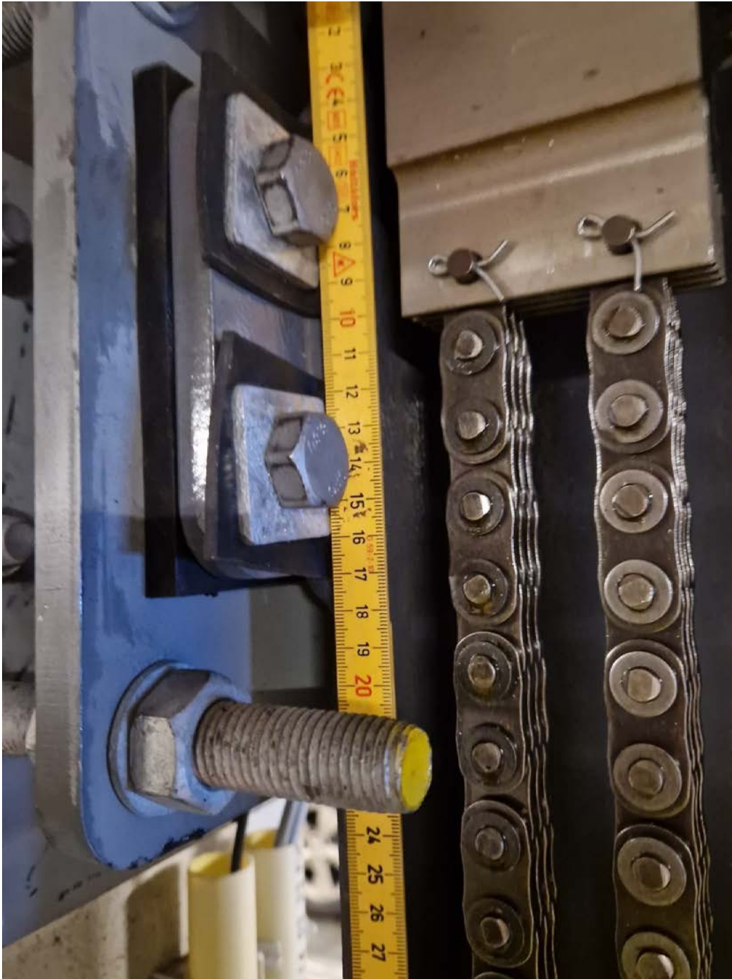
Foto 69: Innfesting mot søyle
