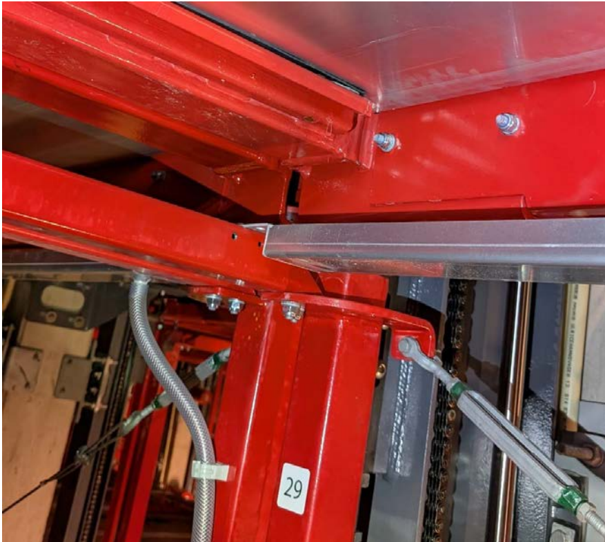
Foto 33: Undersiden av plattform BK2 med renne og slange for drenering
