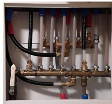
Tekniske anlegg, VVS anlegg (Sjekkpunkter utover det som er inkludert i andre rom) - [Fordelerskap til rør-i-rør system - Bod]
