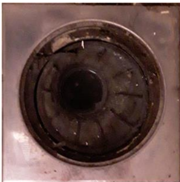
Våtrom - [Sluk - Vaskerom]
