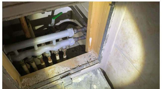
Flislagt vegg mellom toalettrom og bad. Ikke foretatt hulltaking. For øvrig betongvegger.
