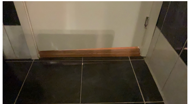
Dør med lufteterskel.
