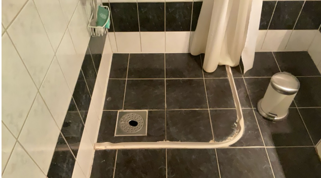
Pålimt plastlist på gulv for å hindre at vann kommer ut på gulvet ved dusjing.
