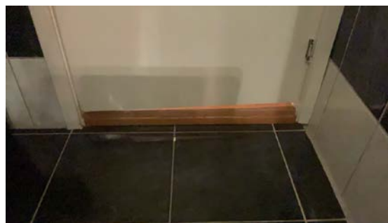
Dør med lufteterskel.
