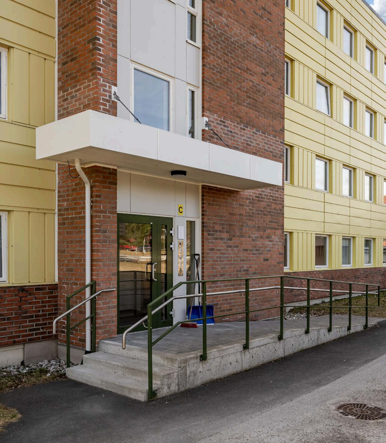
Overbygget inngangsparti med callinganlegg.
