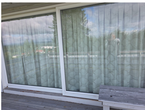
skyvedør terrasse 1.etasje
