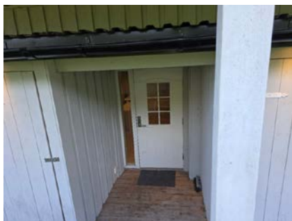
Ytterdør kjeller mot vest
