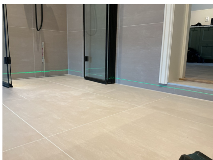
Fallforhold er kontrollert.
