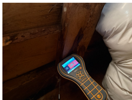
Bilde fra fuktmåling i undertak.
