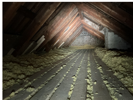
Det er etablert gangbane på kaldtloftet.
