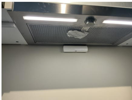
Avtrekkseffekt er testet med papir.
