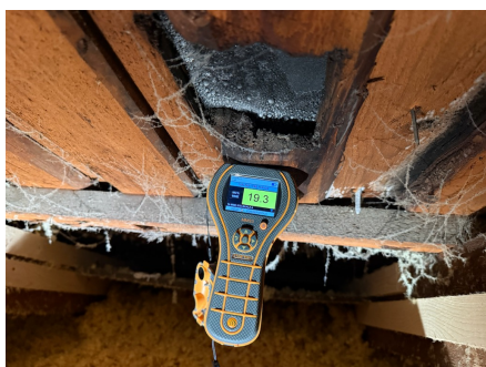
Bilde fra fuktmåling i undertak.
