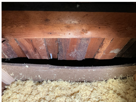
Det er etablert luftespalte på ombygd del.
