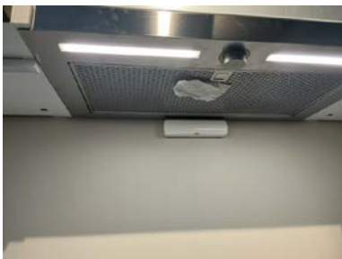
Avtrekkseffekt er testet med papir.
