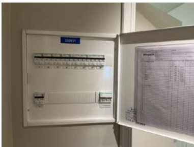
Sikringsskap med automatsikringer.
