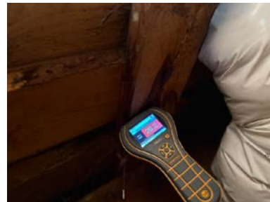
Bilde fra fuktmåling i undertak.
