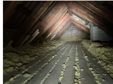
Det er etablert gangbane på kaldtloftet.
