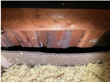
Det er etablert luftespalte på ombygd del.
