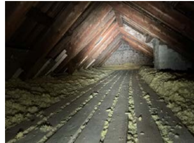
Det er etablert gangbane på kaldtloftet.
