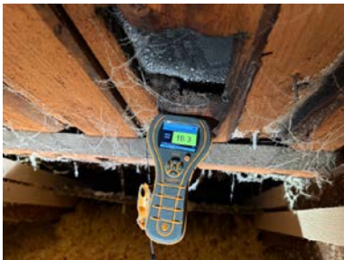
Bilde fra fuktmåling i undertak.
