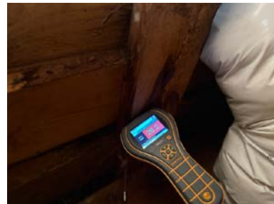
Bilde fra fuktmåling i undertak.
