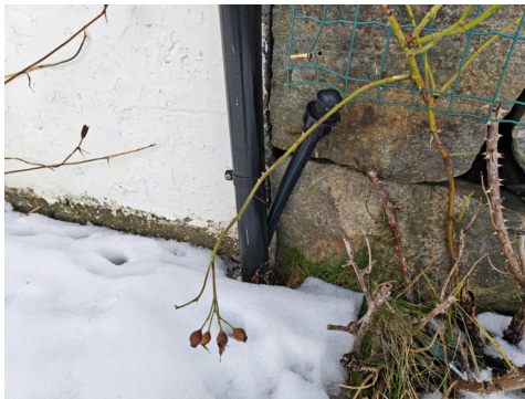
Ny ledning lagt inntil grunnmur.
