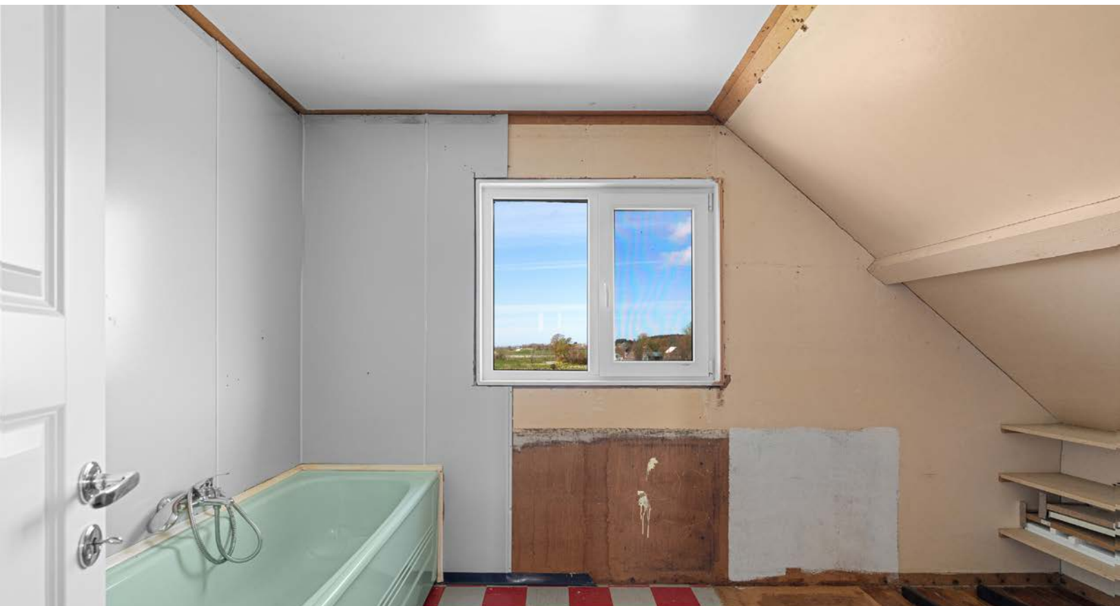
Bad i 2. etasje er påbegynt arbeid og klart for videre oppussing
