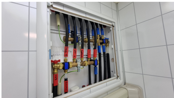
Kontroll av rørfordelerskap.
