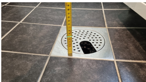
Kontroll av fall.
