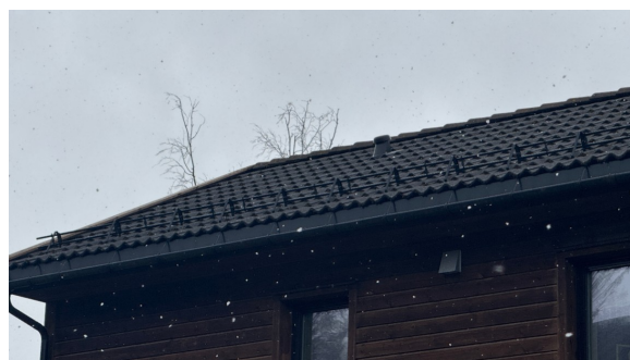
Inspeksjon av taktekke fra bakkenivå.
