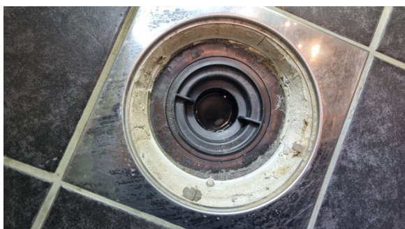
Kontroll av sluk.
