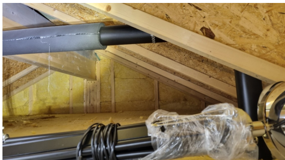
Inspeksjon av takkonstruksjonen.
