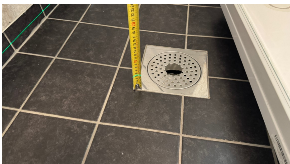
Kontroll av sluk.
