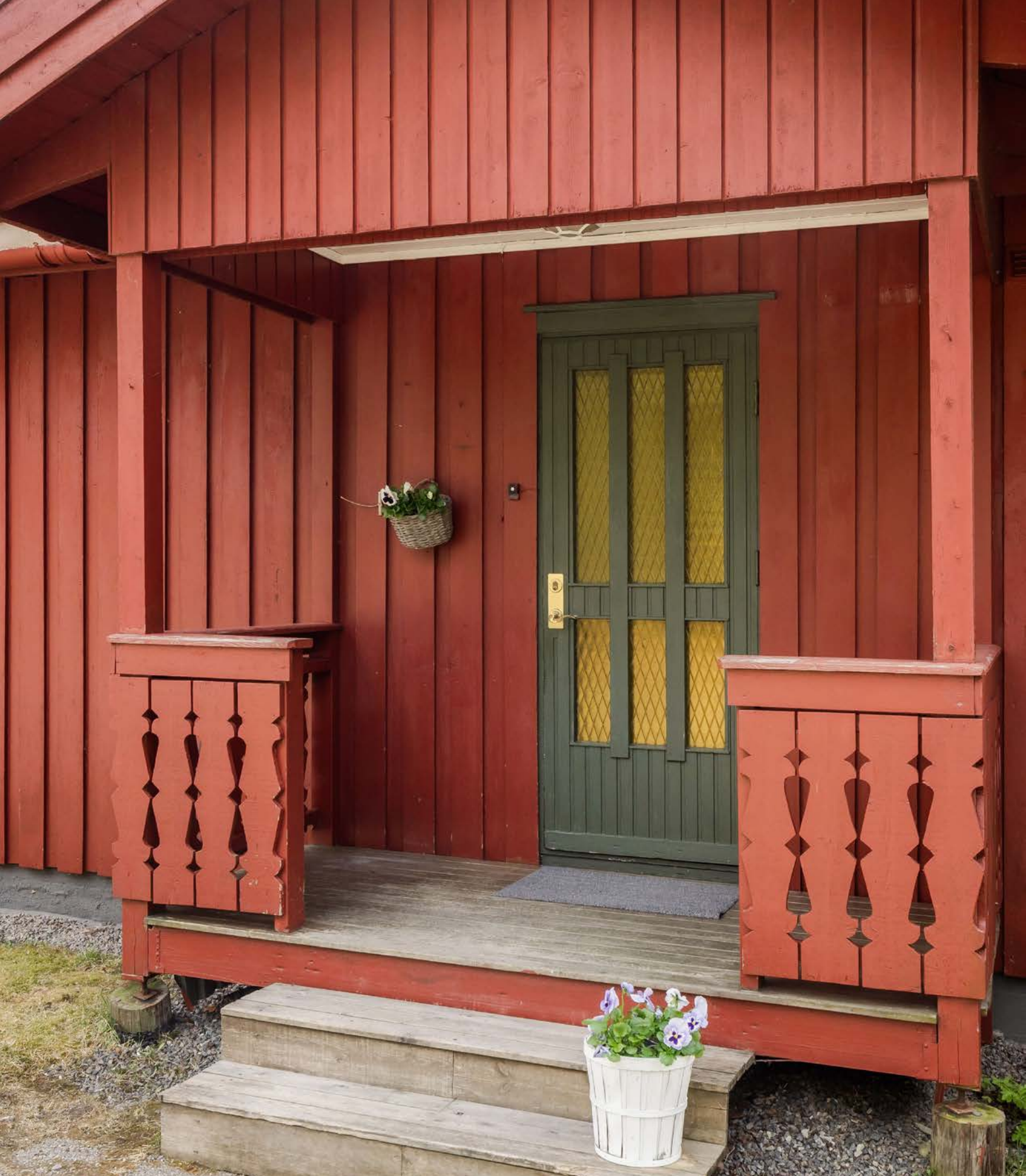
Du ønskes velkommen inn via et hyggelig inngangsparti. Tilbygg med med overbygget takkonstruksjon over inngang i 1988.
