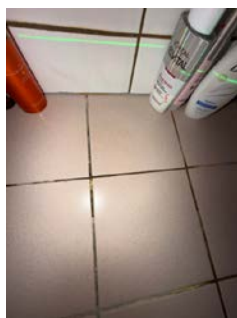
mangler fugemasse flere plasser
