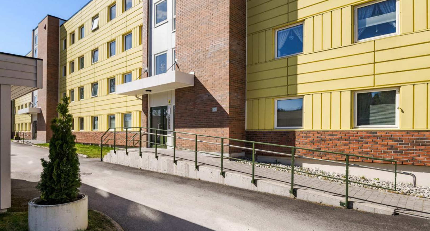
Overbygget inngangsparti med callinganlegg.
