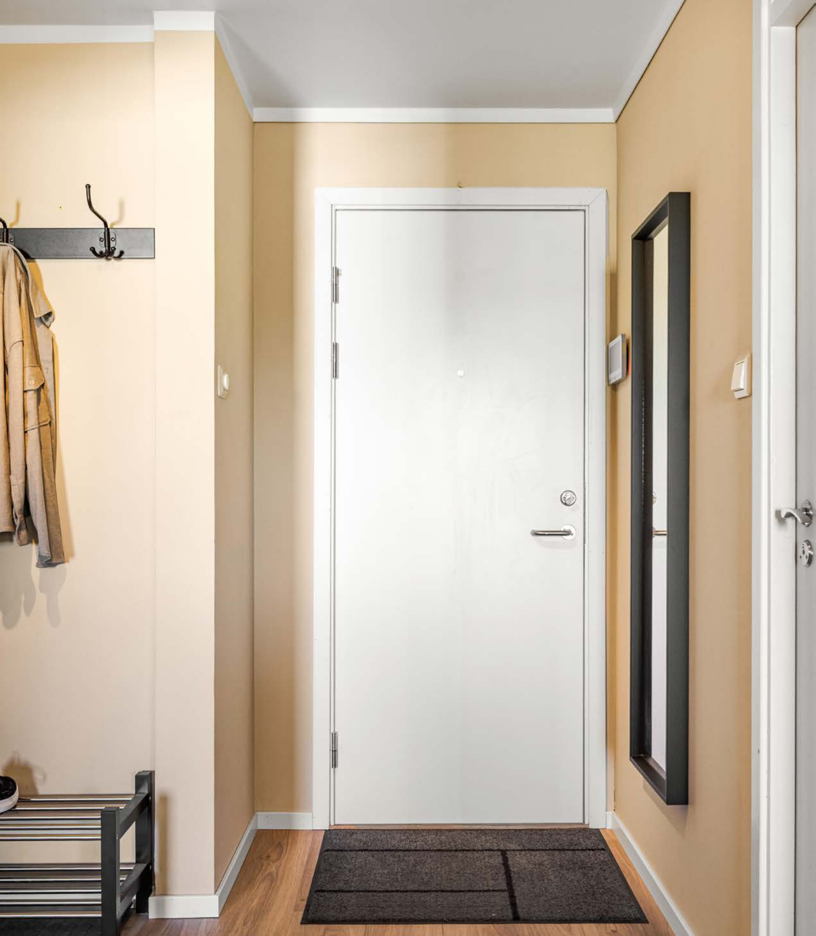
Montert callinganlegg med video på vegg ved inngangsdøren.
