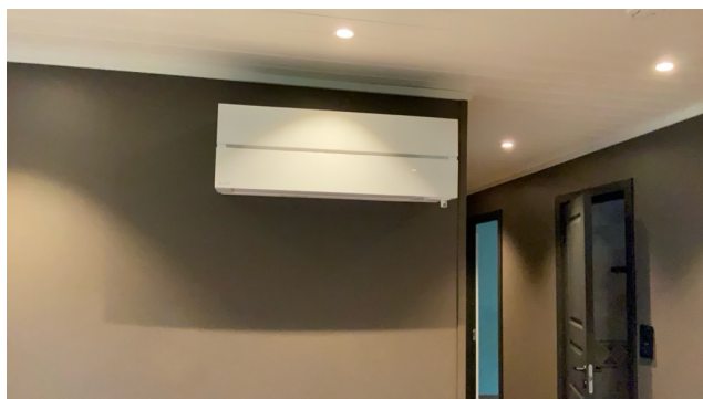
Varmepumpe.
