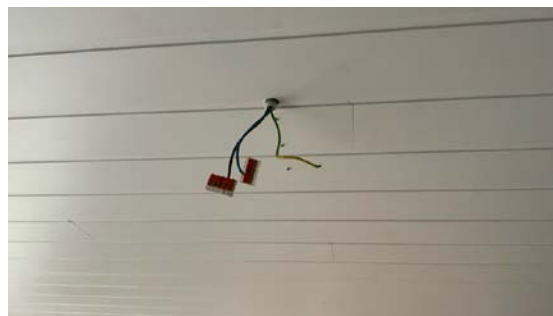
Synlige ledninger (takpunkter).
