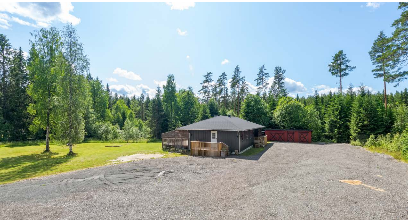
Det er en liten terrasse utenfor vaskerom.
