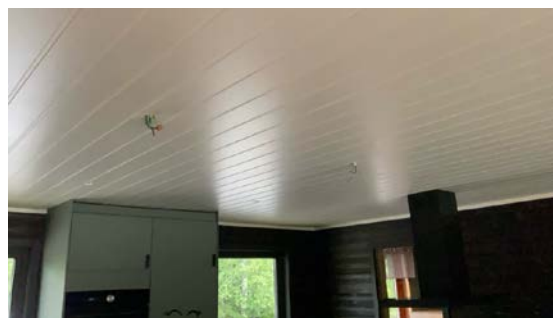
Synlige ledninger (takpunkter).
