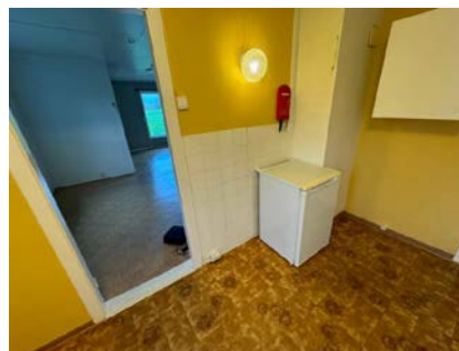
Ikke montert ventilator.
