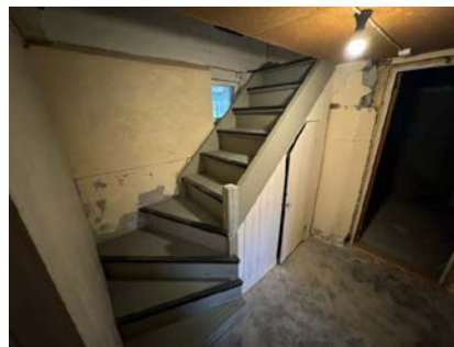
Manglende rekkverk.
