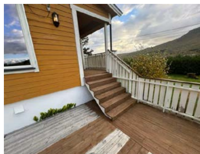
Manglende rekkverk.
