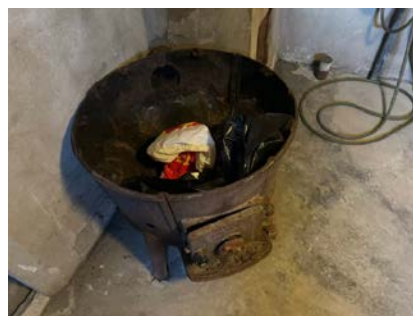
Delvis demontert vedovn i kjelleren.
