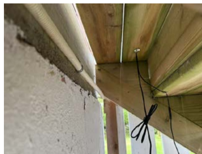
Trappen er løsnet fra altanen.
