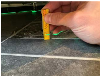
Måling ved sluk.
