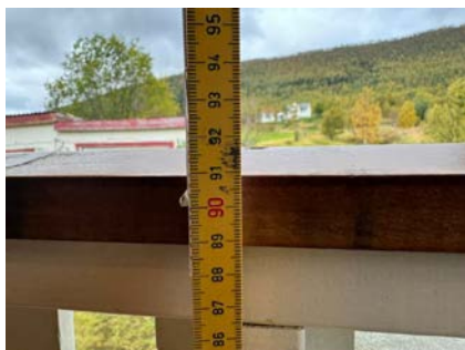
Høyde på rekkverket.
