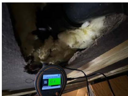
Fuktmåling ved sluk.
