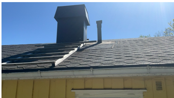
Reparertettet midlertidig på tak av eier.
