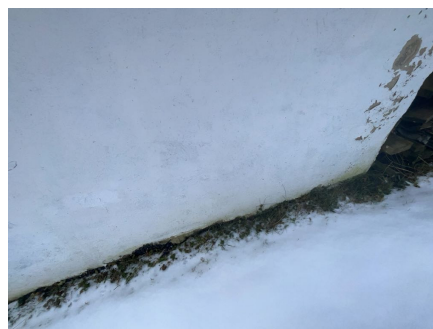
Synlig fuktsikring på bod under garasje.
