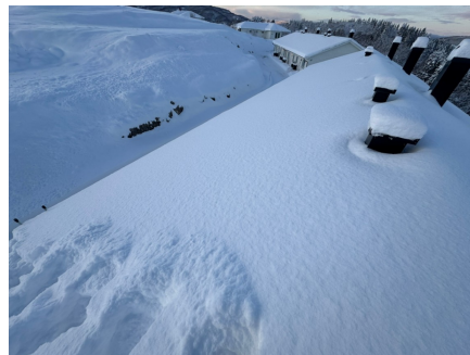
Taktekkingen er snødekt.
