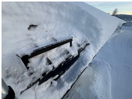
Taktekkingen er snødekt.
