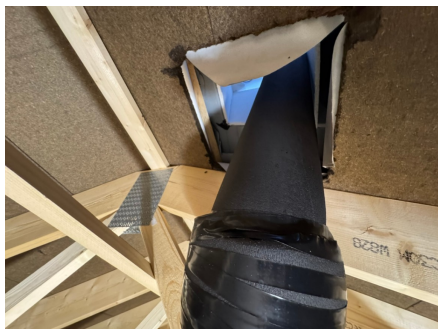
Utett rørgjennomføring.
