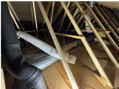
Avtrekket til isolasjonen er avsluttet på kaldloftet.
