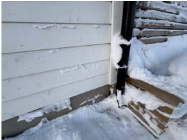
Takrennedløp er avsluttet over terreng ved grunnmuren.
